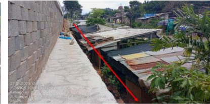
Pemasangan pipa HDPE 200 mm di samping saluran drainase dan bangunan semi permanen, metode boring manual.
