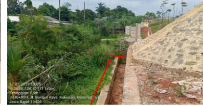
Pemasangan pipa HDPE 200 mm di samping saluran drainase dan dibawah rumput liar, metode boring manual.
