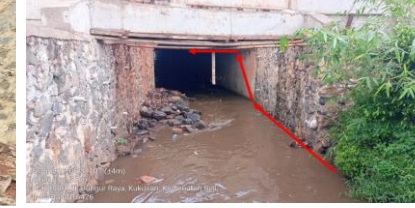
Pemasangan pipa HDPE 200 mm di dasar sungai dan GI 200 mm di dalam box culvert posisi kanan atas, metode boring manual dan menggunakan plat penggantung
