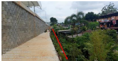
Pemasangan pipa HDPE 200 mm di samping saluran drainase dan dibawah tanaman hias, metode boring manual.
