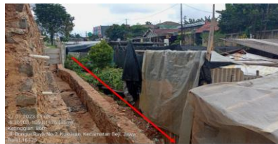
Pemasangan pipa HDPE 200 mm di samping saluran drainase dan bangunan semi permanen, metode boring manual.
