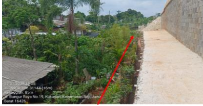
Pemasangan pipa HDPE 200 mm di samping saluran drainase dan dibawah tanaman hias, metode boring manual.
