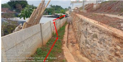
Crossing dibawah pagar beton dari lahan Tol ke lahan Pertagas, metode boring manual.
